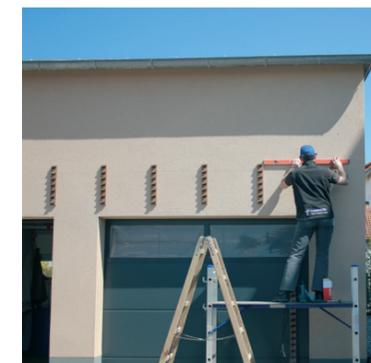
Установите Лаги вертикально, производя выравнивание по горизонтали. Расстояние между лагами – 600 мм.
