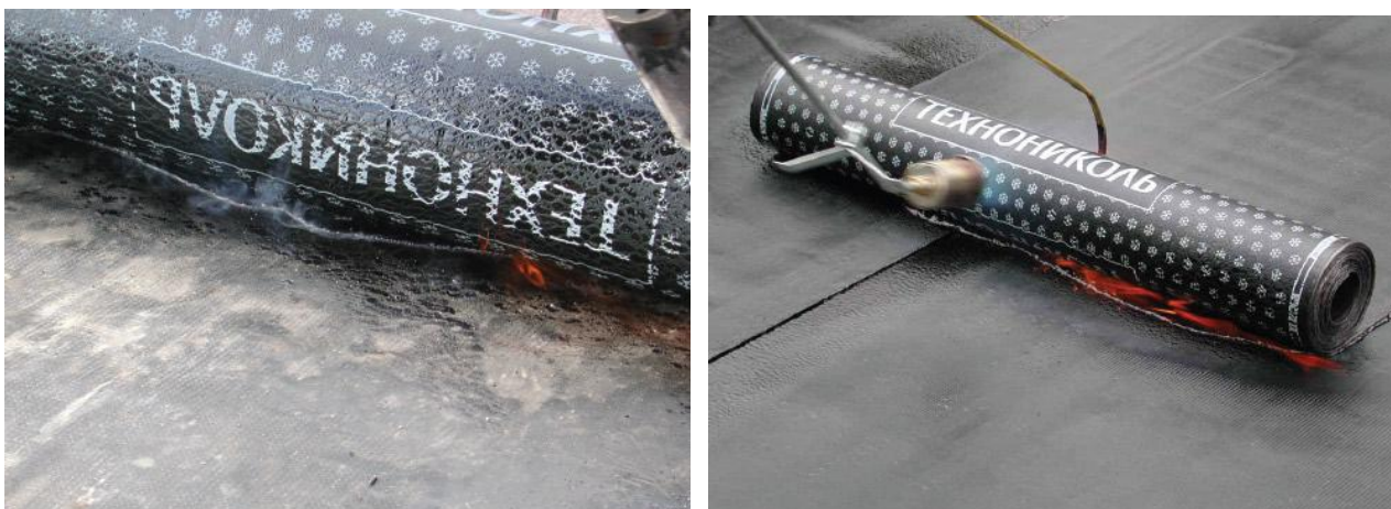
35 pav. Ištirpintos polimerinės - bituminės masės „banga“
