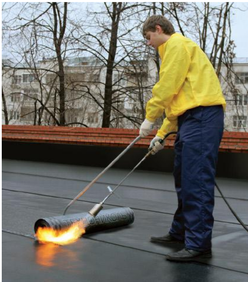
33 pav. Stogdengio padėtis dengiant stogą.
